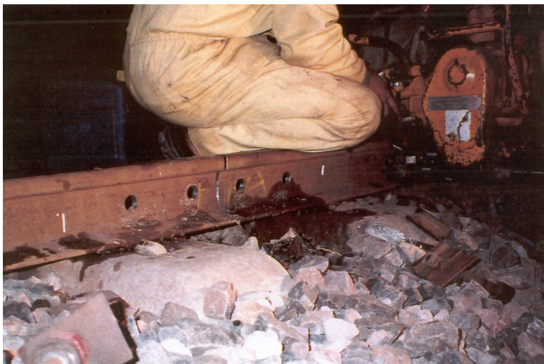
Figura 4 – Operação de furação do carril.
