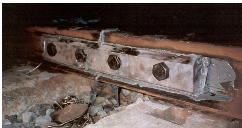
Figura 17 – Aspecto da junta após o aperto da fixação.
