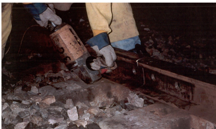
Figura 5 – Operação de limpeza do carril.
