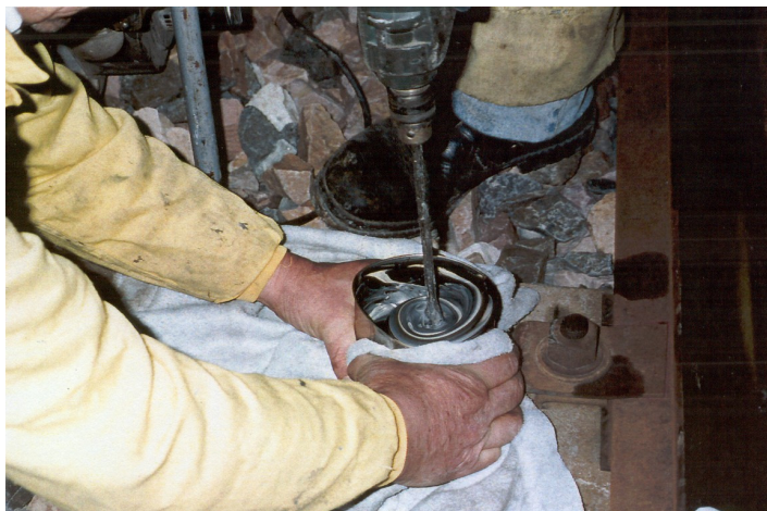
Figura 9 – Procedimento de mistura dos componentes da cola.
