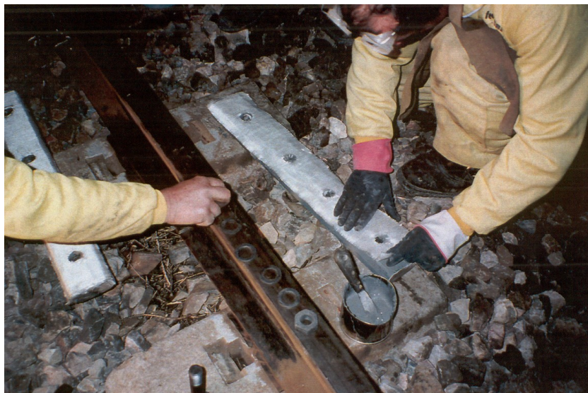
Figura 11 – Colocação das redes de fibra de vidro sobre a barreta.
