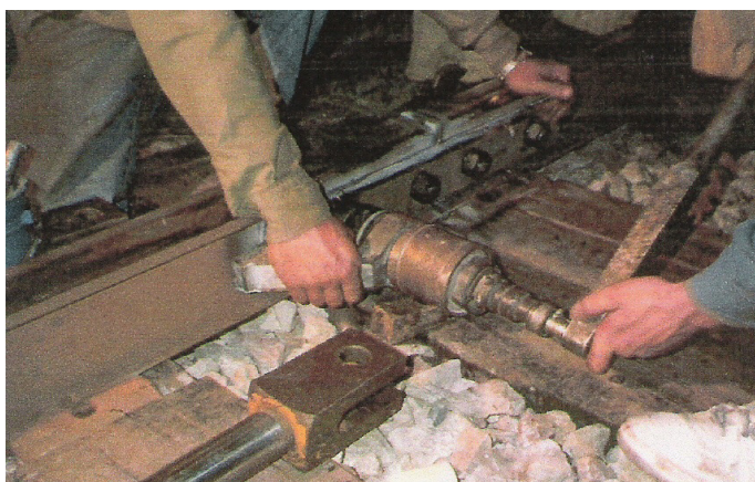
Figura 16 – Aperto da fixação.
