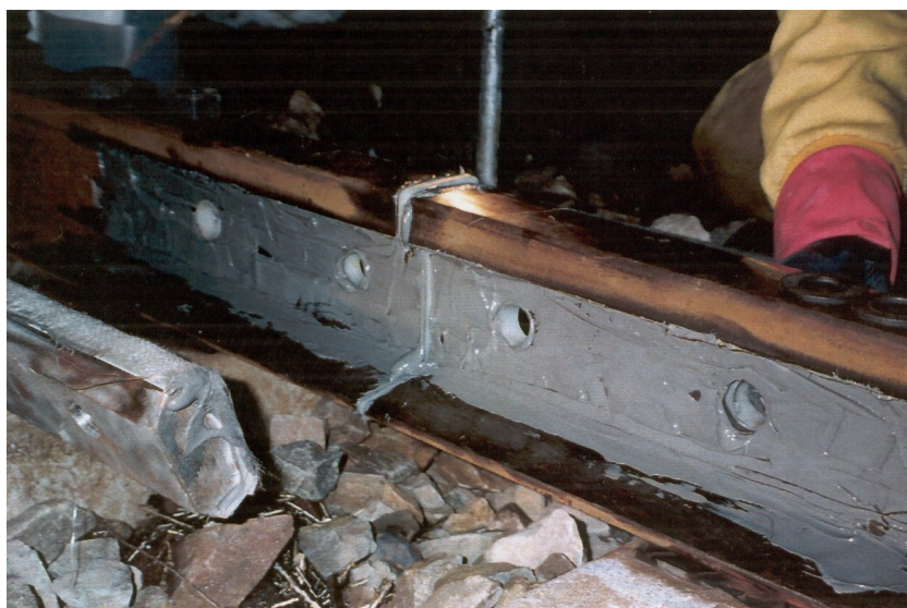
Figura 12 – Aplicação da cola na alma do carril.
