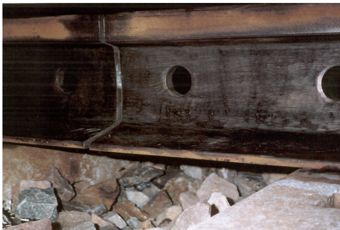
Figura 6 – Carril cortado, furado e rebarbado.
