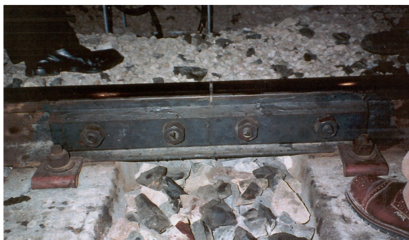
Figura 18 – Aspecto da junta no final da montagem.
