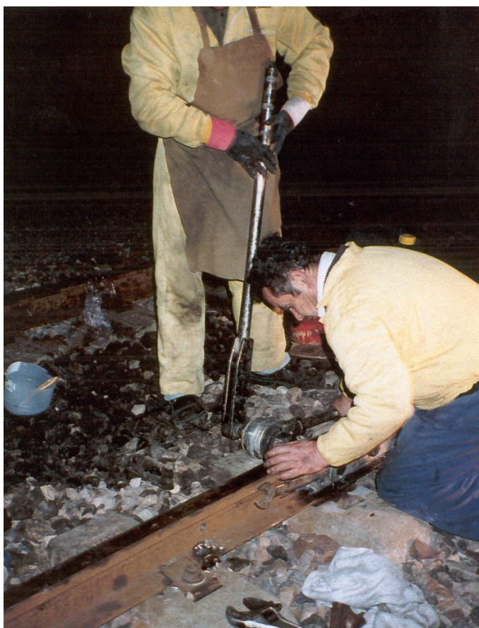
Figura 14 – Operação de aperto da fixação.
