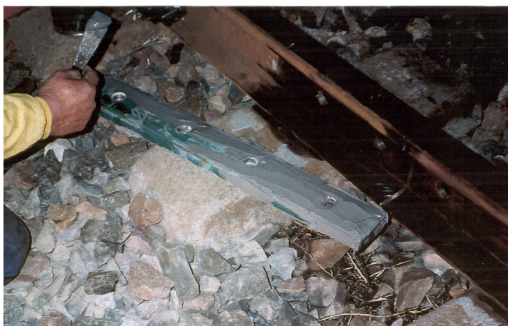
Figura 10 – Aplicação da cola na barreta.
