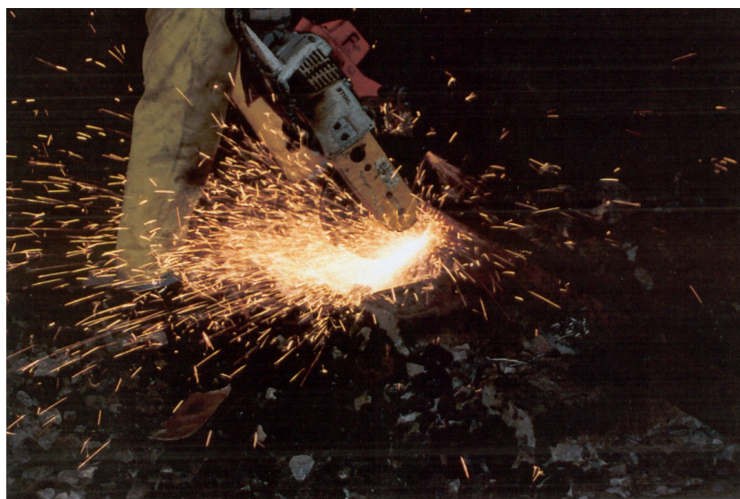
Figura 3 – Operação de corte de carril.
